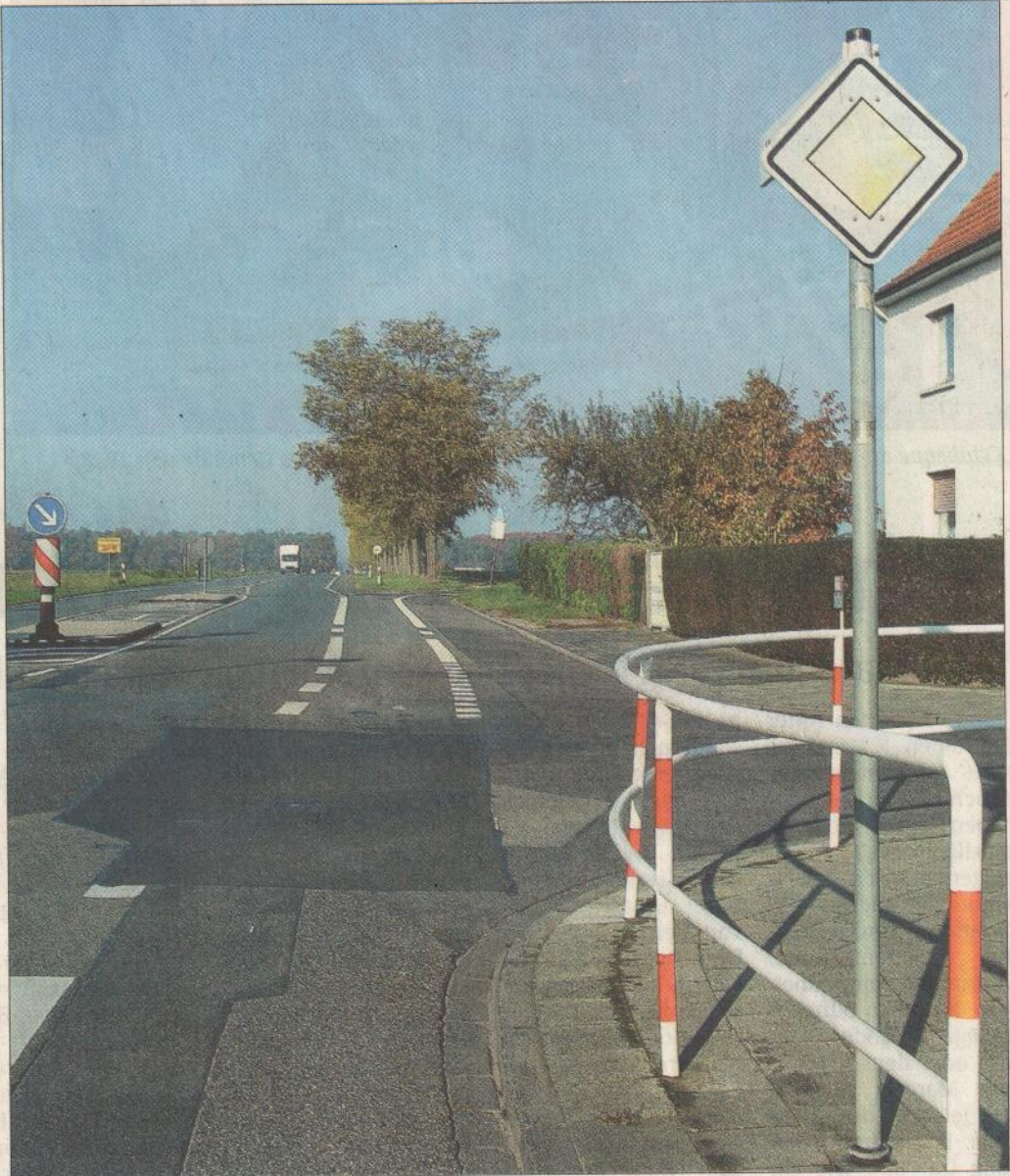
Radweg oder Extra-Spur für Autos? Die verwirrende Fahrbahnmarkierung am Rembrücker Ortsausgang gefährdet Radfahrer. Grund: Autofahrer, die von der Obertshäuser Straße rechts in die Landstraße einbiegen, benutzen den Radweg-Ausläufer oft zum Einfädeln. Foto: dra
